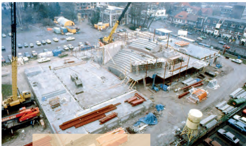
Bouw van de theaterzaal, gezien vanaf de flat aan de Duivenwal (Cord Otting, collectie Gemeentearchief Veenendaal)
