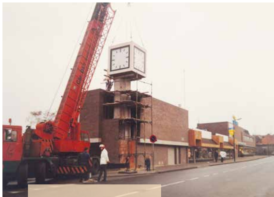
In 1978 wordt de toren geplaatst (Foto: Horlogerie Van Manen, Collectie Bouwbedrijf Davelaar)
