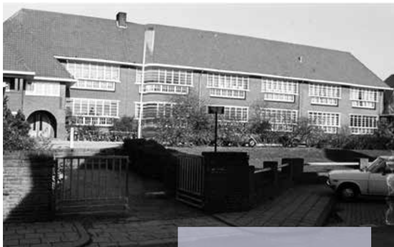
Het gebouw van de Wilhelminamavo aan de Wilhelminastraat in Rhenen, 1977 (collectie Regionaal Archief Zuid-Utrecht).
