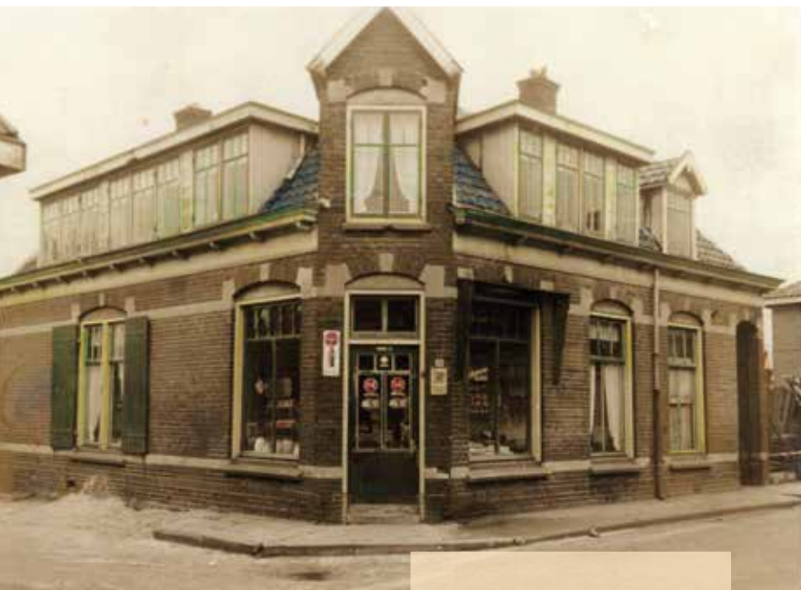
Het inmiddels afgebroken pand van bakkerij Bolderman aan de Achterkerkstraat (Collectie Constant van den Heuvel)
