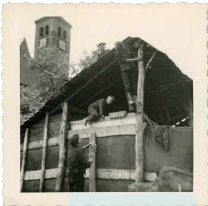
Achter de opslagloods is de Julianakerk zichtbaar 1963 (Collectie Henk van Voskuilen)
