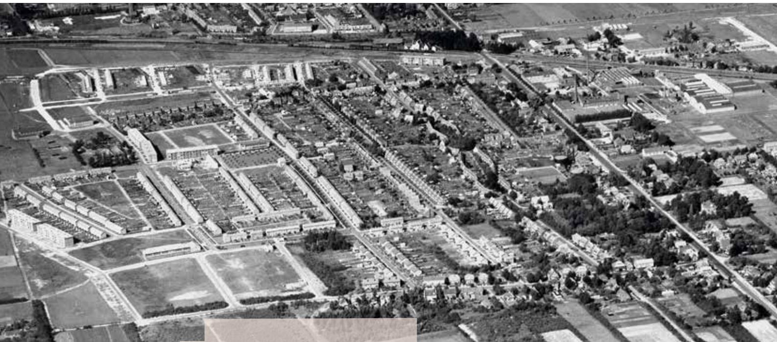
Luchtfoto uit 1955 van het Franse Gat in aanbouw. (Collectie Gemeentearchief Veenendaal)
