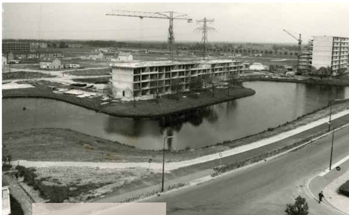
Flats aan De Grote Pekken in aanbouw, 1967/1968. (Collectie Gemeentearchief Veenendaal)
