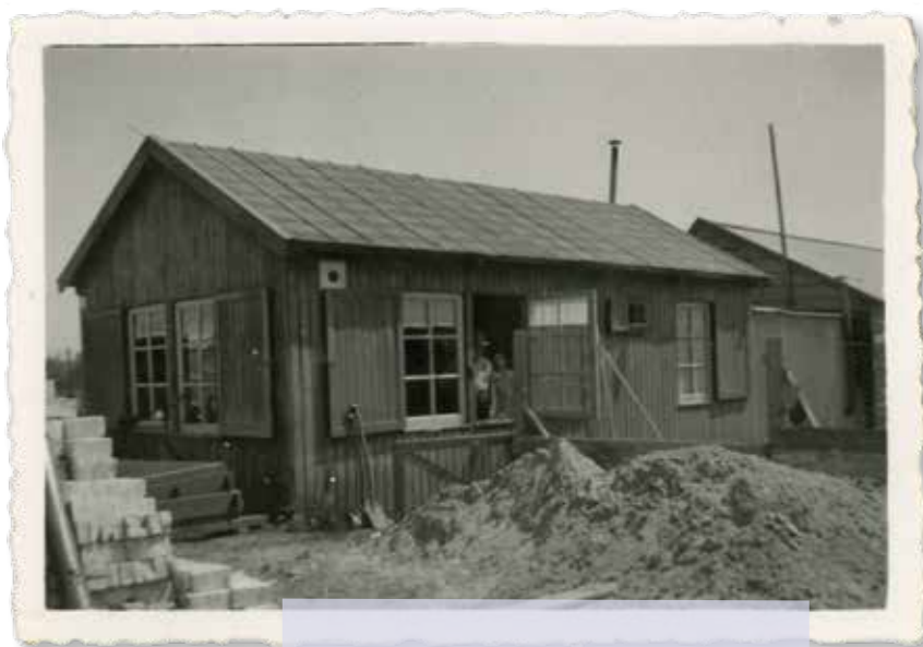
Noodwoning in het zogenaamde kamp Dijkstraat; dit kamp heeft dienst gedaan voor het Nederlandse leger, voor de Arbeidsdienst en het Duitse leger tijdens de oorlog 1940-1945 en voor het onderbrengen van woningbehoeftigen na de oorlog. Ook was hier tijdens de oorlog het ziekenhuis uit Wageningen ondergebracht. (Collectie gemeentearchief Veenendaal)
