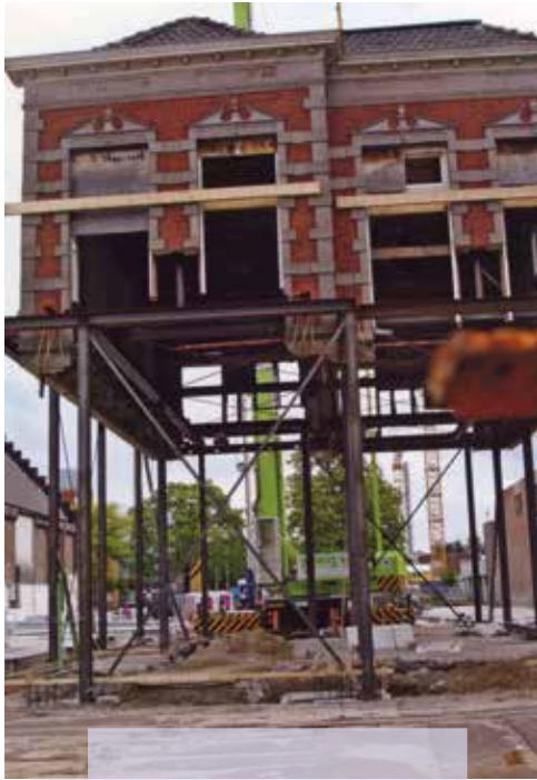
Foto van de bovenverdieping met stalen constructie. (Collectie gemeentearchief Veenendaal)
