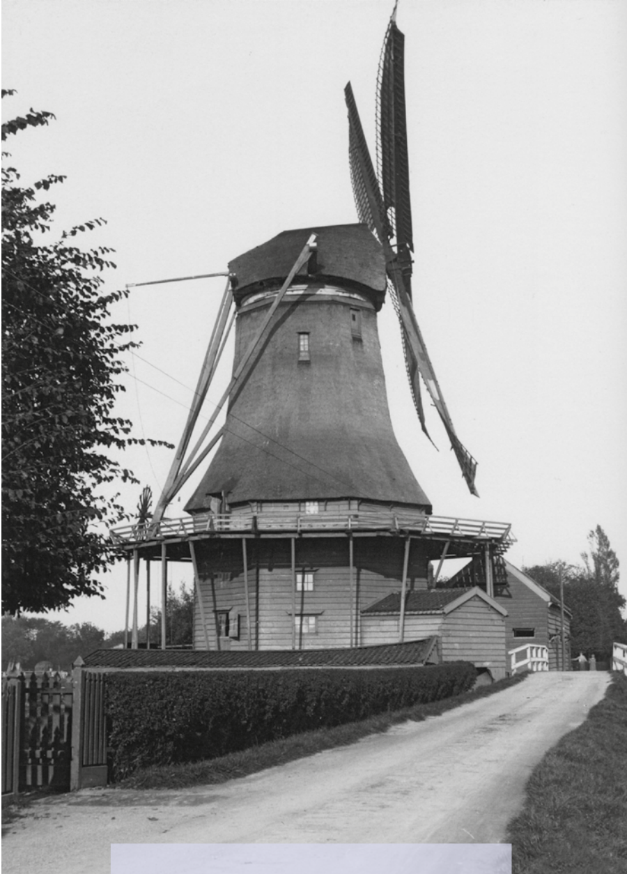
Zaanse korenmolen 'Het Wapen van Oostzaan' met de achtkante houten onderbouw. Deze molen was uitgerust met 3 koppel maalstenen en werd gesloopt in 1920. (foto Zaanse archief)
