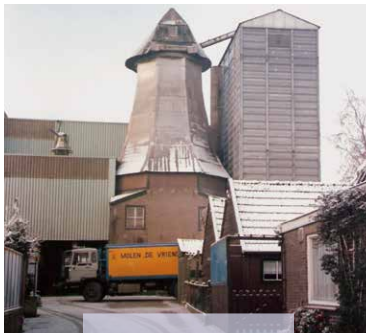
De onttakelde molen met rondom de silo's. De overgang van vierkant naar achtkant is hier ook goed te zien (Collectie Gert van Eden)
