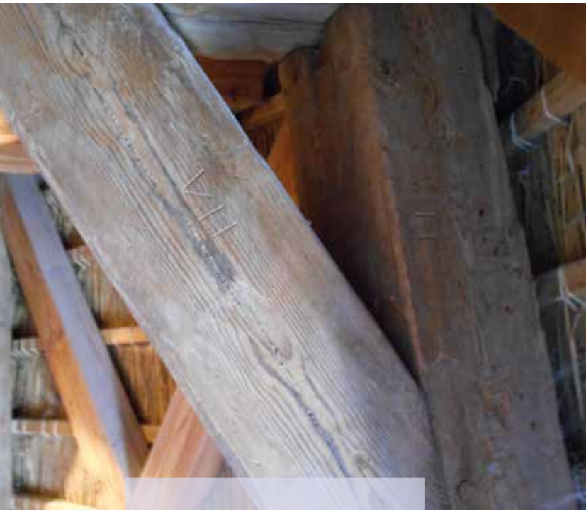
Markeringen in de balken van molen De Vriendschap (Collectie Leen Boot)
