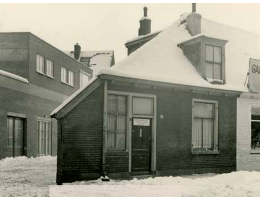
Onbewoonbaar verklaarde woning, Zandstraat 17, op de hoek van de Zandstraat/ Fluiterstraat. Links gaat men de Fluiterstraat in, 1956 (collectie Gemeentearchief Veenendaal)
