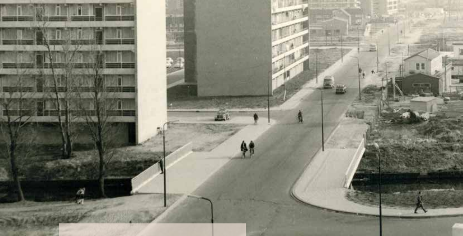
Boompjesgoed met aan de rechterzijde het begin van de bouwwerkzaamheden voor het nieuwe politiebureau, 1968 (collectie Gemeentearchief Veenendaal)
