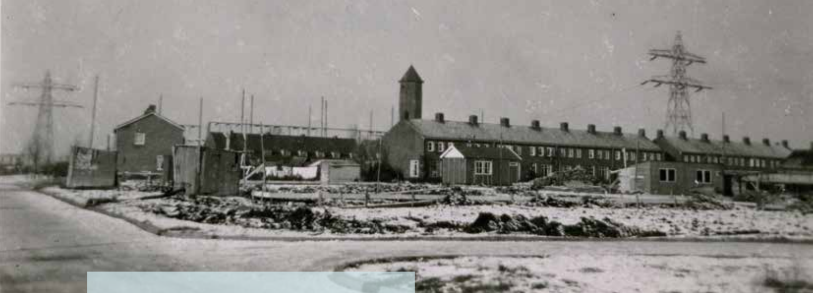
De school op de Stationssingel in aanbouw. De watertoren aan de Kanaalweg is goed zichtbaar (collectie Gemeentearchief Veenendaal)
