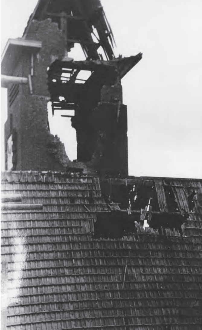
De toren en het dak van de Julianakerk na beschietingen door de geallieerden in april 1945 (collectie Gemeentearchief Veenendaal)
