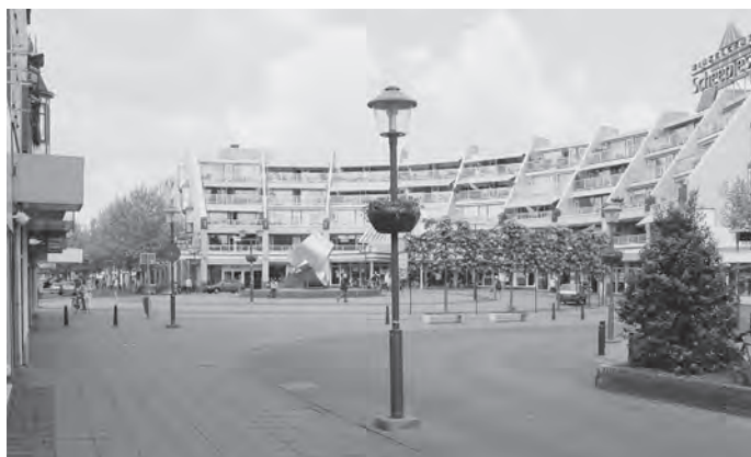
Het Scheepjeshofplein met het winkelcentrum Scheepjeshof gezien vanuit de Hoogstraat in de richting van de Zandstraat, 2003 (collectie Gemeentearchief Veenendaal)
