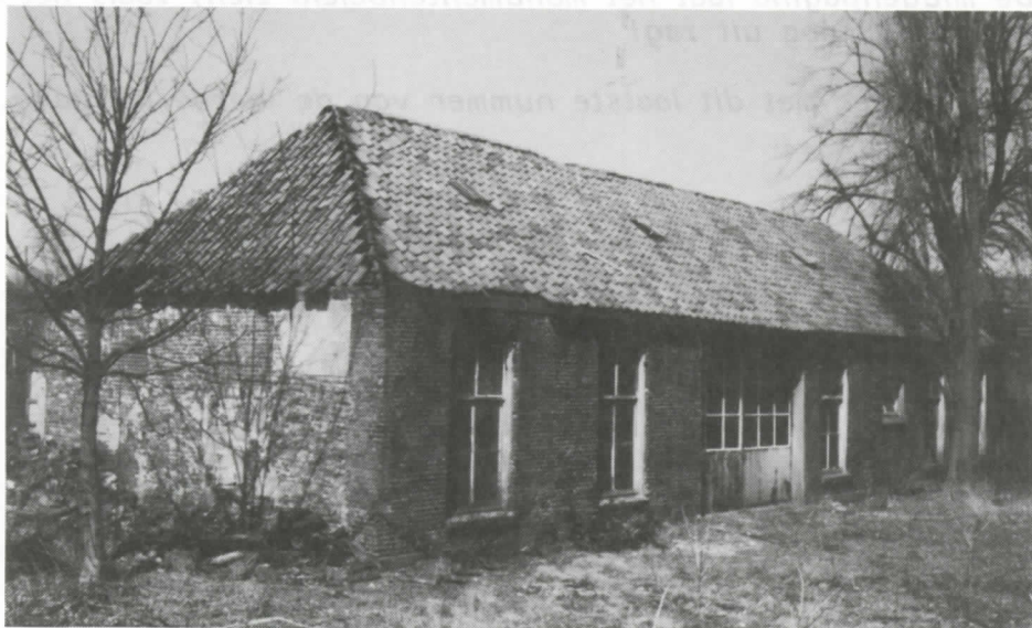
Het 'Kousenfabriekje', het blokje arbeiderswoningen aan de Vendelseweg 7-15: half oktober gesloopt.
