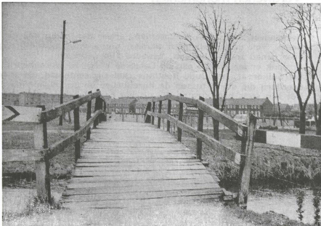
De Geerbrug bij het spoorwachtershuisje. Op de achtergrond het Franse Gat.
