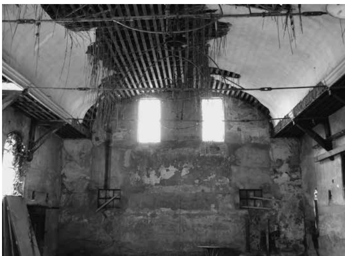
Het interieur van de kerk met een goed zicht op de vorm van het gestukadoorde plafond en de aantasting door het verval (foto Leen Boot, 2011)
