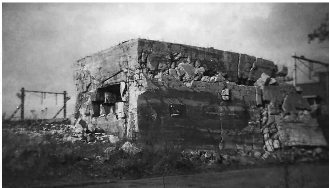
De bunker aan het Boveneind in De Klomp na de explosie. Op de achtergrond is de spoorlijn en rechts een stukje van het gebouw van Coöperatie De Klomp zichtbaar (collectie M. Methorst, Veenendaal)
