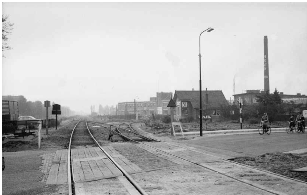
Een van de geplande tramlijnen wilde men vanaf Elst door Veenendaal in de richting van Wageningen laten lopen. In dat geval zou de tram naast het station aan de Kerkewijk de spoorweg moeten kruisen. Spoorweghuisje 31 is in oktober 1994 gesloopt om plaats te maken voor een polikliniek (foto J.G.C. van de Meene, circa 1958)
