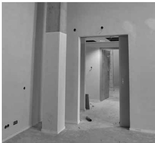
De pantry en de ingang van het archief ( collectie H. Henzen )
