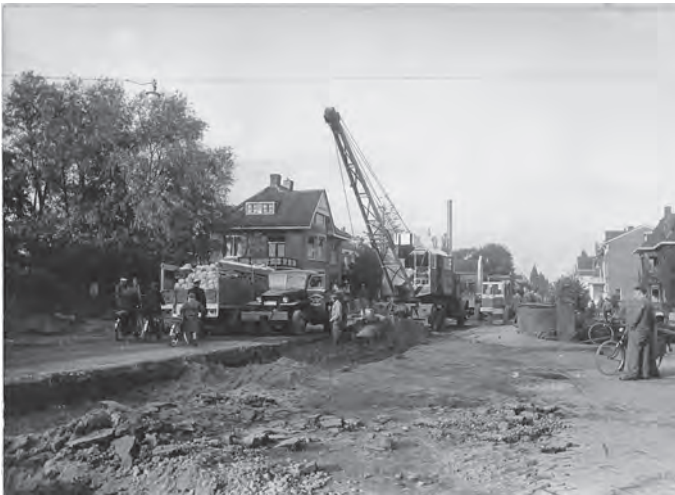
Het uitgraven van de Kerkewijk ter hoogte van de Panter Sigarenfabrieken (collectie J. van Schoonhoven)
