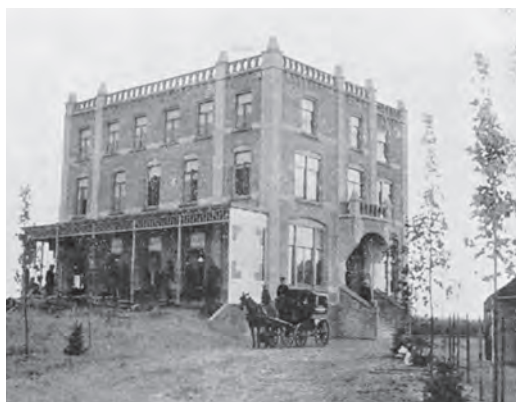
De koets van De Haas bij Berg en Bosch. Links de noordgevel met de veranda, rechts de westgevel met de hoofdingang. Geheel rechts het pomphuisje van de watervoorziening, 1908 ( Oud Rhenen, september 2006 ).
