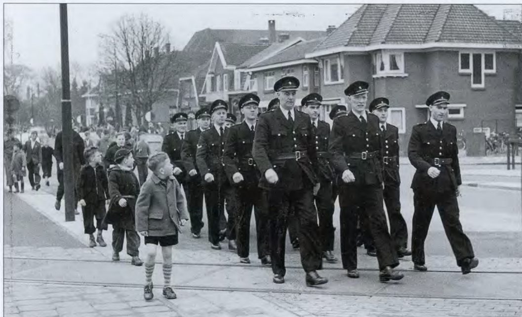
Op de derde foto lopen politieagenten en reservisten over de Kerkewijk ter hoogte van de panden die onlangs zijn afgebroken om plaats te maken voor een nieuw appartementencomplex op de hoek Kerkewijk/Rembrandtlaan. We zijn zeer benieuwd naar de reacties en het zou leuk zijn ook de namen van de geïmponeerde kinderen te horen.
