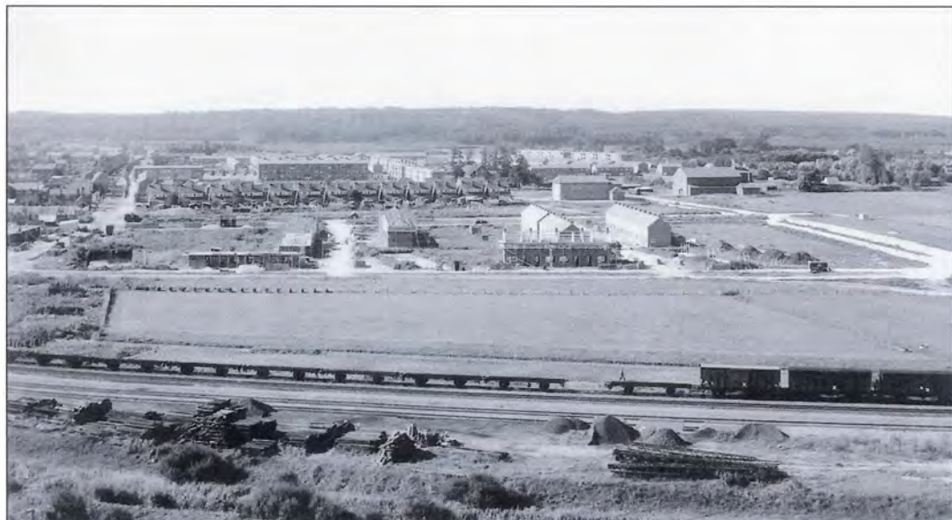
De Rembrandtlaan, de Frans Halslaan, de Meindert Hobbemastraat, de Jacob van Ruysdaelstraat en de Adriaen van Ostadelaan: het Franse Gat in aanbouw, omstreeks 1955. Op de voorgrond het spoor, op de achtergrond de Heuvelrug. (Collectie Gemeentearchief Veenendaal.)
