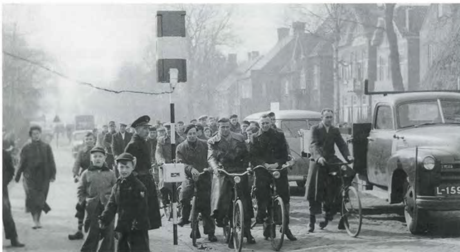
Tijdens de renovatie van de Kerkewijk tussen Markt en Vaartbrug, 1958 (coll. Hennie Henzen).
