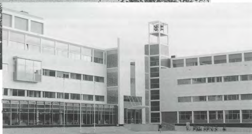
Het geheel gerenoveerde gemeentehuis dat in het voorjaar van 1999 in gebruik is genomen (foto collectie J. Mouthaan).
