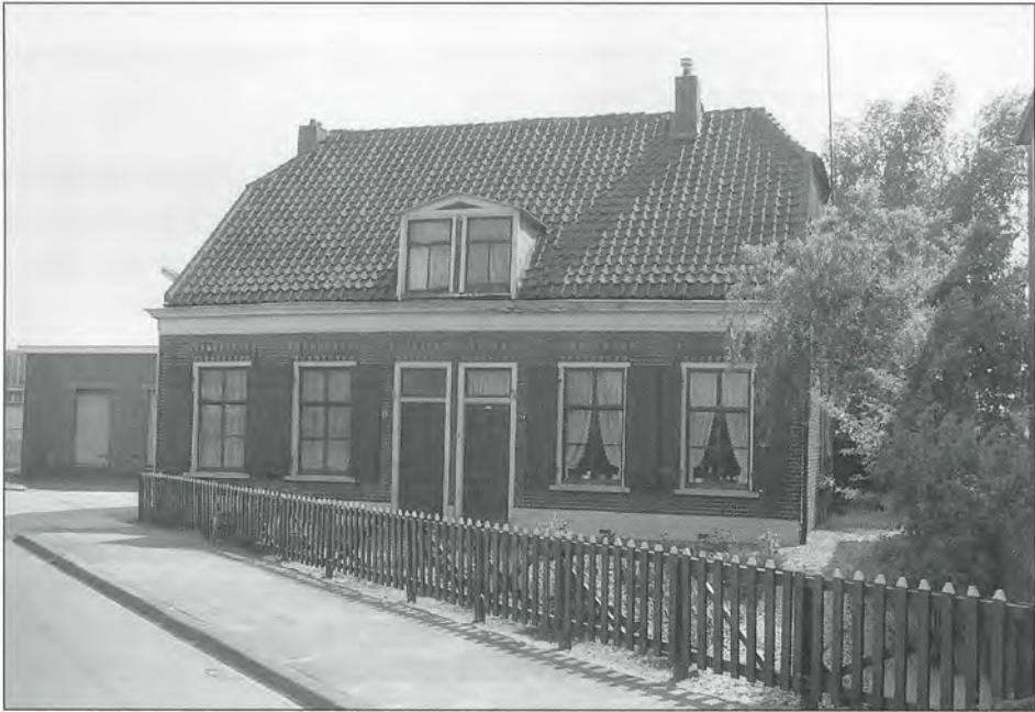
Bedrijfswoning op het fabrieksterrein van de Neveda. Evenals het complex inmiddels gesloopt
