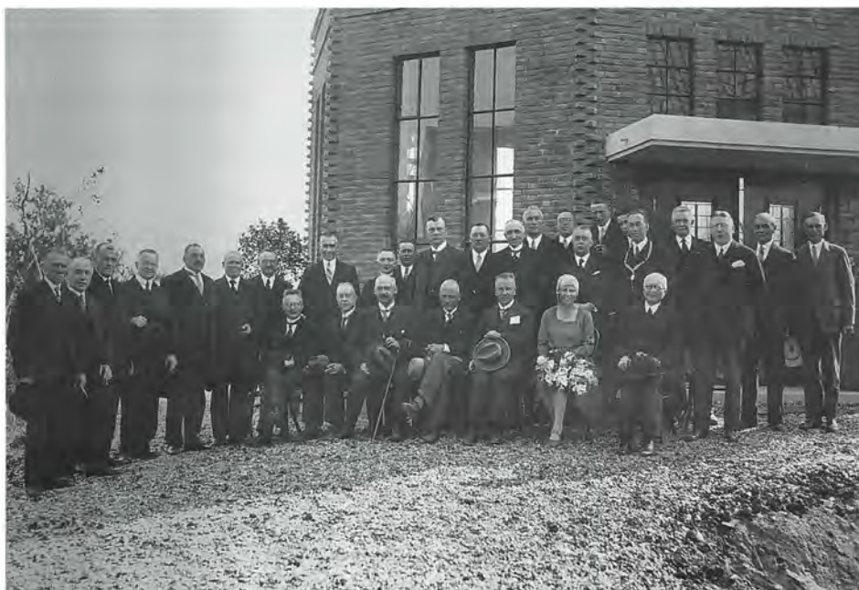
Officiële opening waterleidingbedrijf/toren op 30 juni 1930 in aanwezigheid van diverse raadsleden (foto Gemeente-archief Veenendaal).
