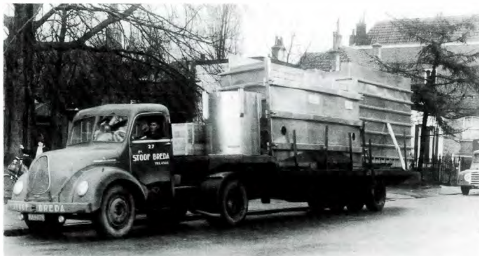
Plaatsing van een ketel (jaren '50). Op de achtergrond het pand van dokter Reijdonk/Nutsspaarbank.
