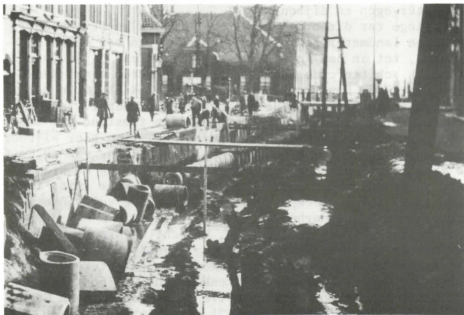
Het dempen van de Grief in de huidige Zandstraat
